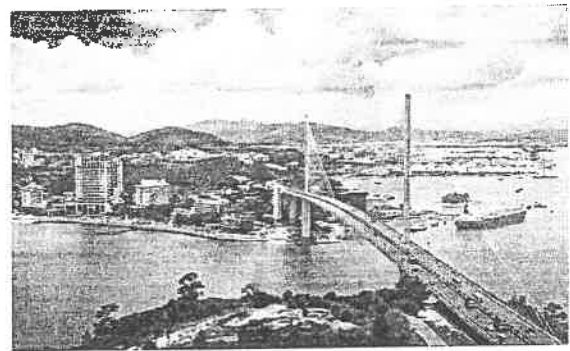
Cầu Bãi Cháy
